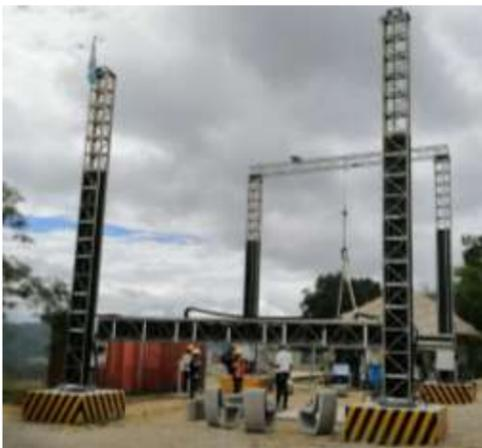
La impresora 3D funciona mediante la colocación de capas horizontales sobrepuestas de tinta, sin la necesidad de utilizar moldes, manteniendo la integridad de las capas y garantizando una excelente adherencia entre ellas.
