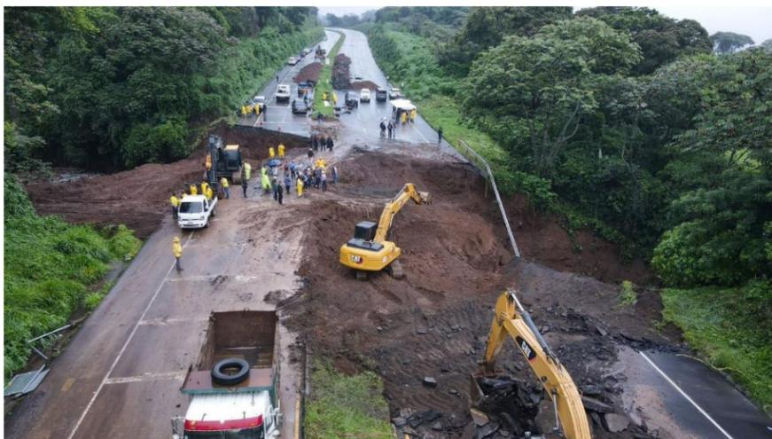
En el caso, del socabamiento de la autopista Palín, Escuintla, hace 18 días, inició el trabajo en el kilómetro 44 de la autopista Palín-Escuintla. La maquinaria completó la primera fase de excavación, hasta llegar a la boca de la tubería. Esta se encuentra a 22 metros de profundidad.
