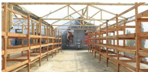
Tienen una estructura básica, están formadas por una base elevada construida con madera, metal, bambú o plástico, la superficie de secado se hace con una malla o tejido permeable, generalmente de polipropileno, que permite el flujo de aire desde abajo y arriba.
