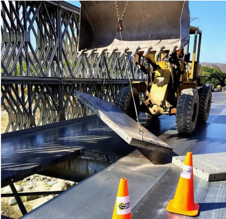
Las planchas son retiradas y sustituidas con el uso de maquinaria especializada, dado su peso y dimensiones. La estructura principal del puente está en buen estado, por lo que solo se realizan ajustes en pernos para reforzar su estabilidad.
